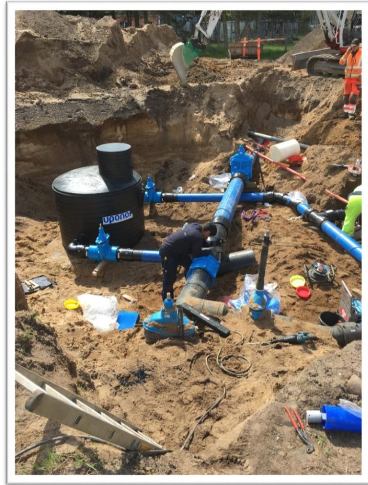
Eablering af ringforbindelse inkl. målerbrønd
